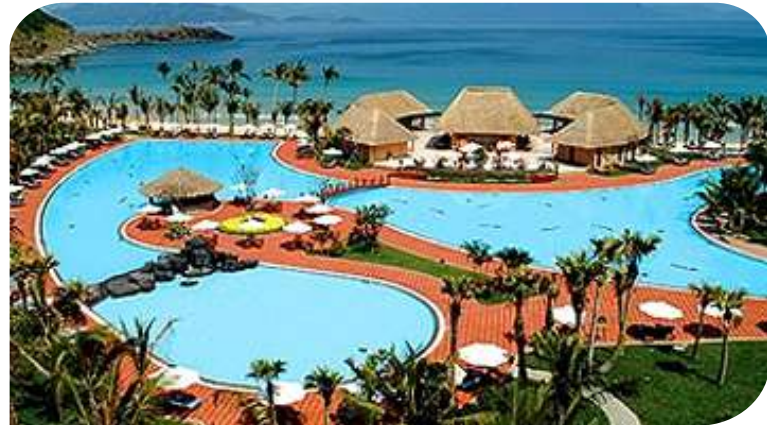
Cung cấp thiết bị điện cho khu Du lịch Hòn Tre.
